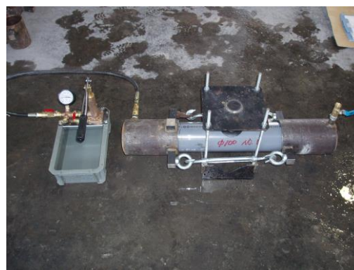
図 9 水圧試験状況
