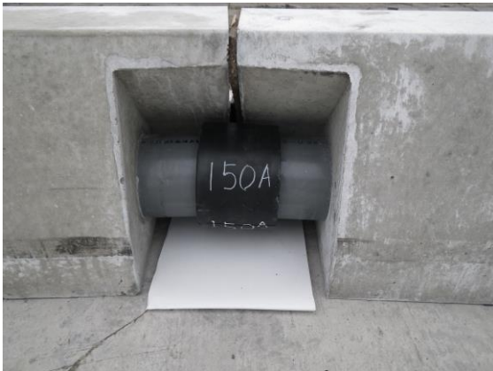
図 12 継手接続状況
