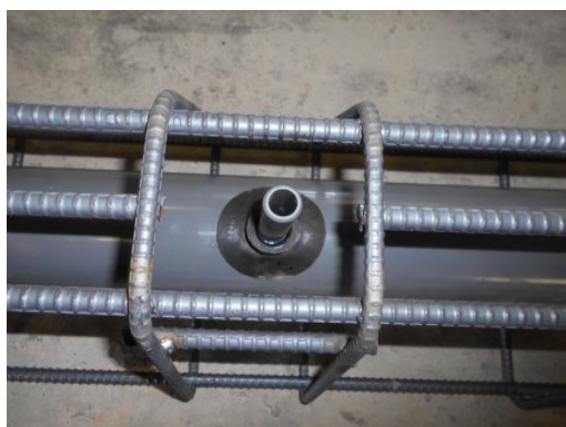
図 8 ゴム製枝管継手接続状況
