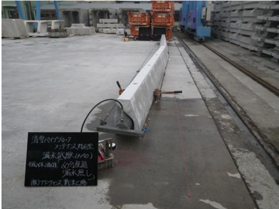
図 10 総合曲げ水圧試験状況全景
